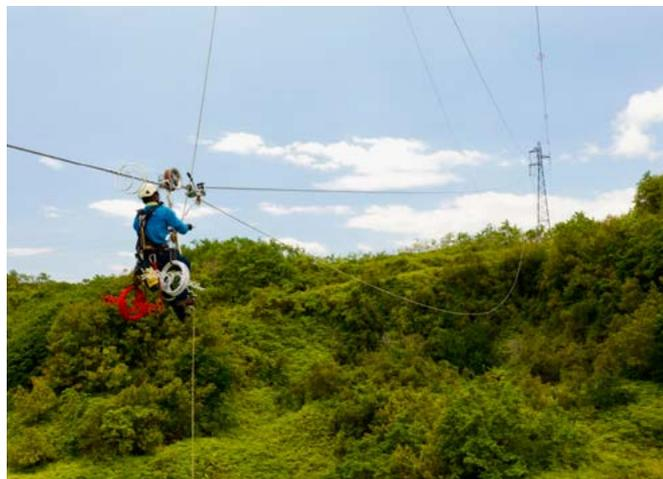
**Figure 38 :** Installation de balises avifaune anticollision sur les lignes hautes tension par les agents EDF pour signaler la présence des lignes. © EDF
