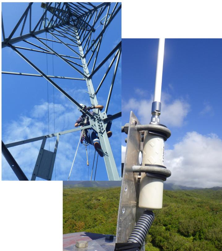
Pose d'antennes par les équipes d'EDF sur des pannes électriques, permettant de suivre en 3D les déplacements des Papanges près des lignes à haute tension.
