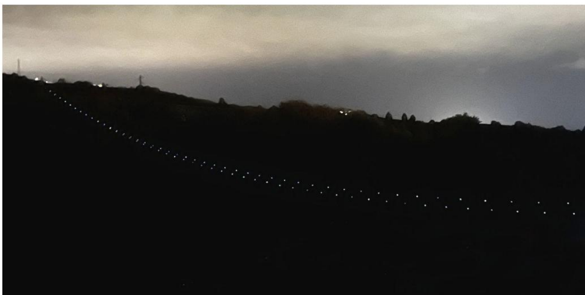
Photographie en pose longue de la portée du site de Rivière du Mât dont 2 des 3 câbles sont équipés de balises. Les lumières produites sont en réalité de courts flashes intermittents.
