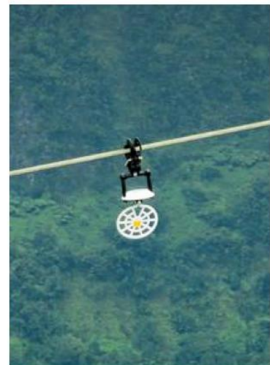
Balises « Raptor Clamp LED » expérimentées sur 2 tronçons de lignes HTB aériennes
